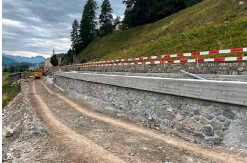
Sanierung Stützmauer Via Nouva (Bild 1 und 2)
